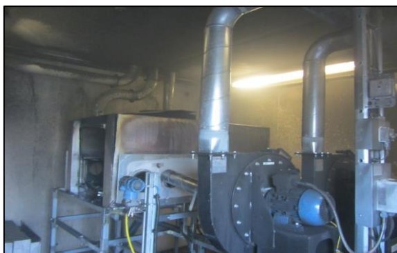
Figur 17 Foton från ytterligare en incident, och där man sedan installerade en ventil i systemet för att öka lufthastigheten. Man demonterade dessutom filterskåpet och evakuerade ventilationsluften ut i det fria. (Nedre foton visar filterrum med respektive utan filterskåp).
