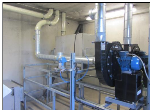
Figur 17 Foton från ytterligare en incident, och där man sedan installerade en ventil i systemet för att öka lufthastigheten. Man demonterade dessutom filterskåpet och evakuerade ventilationsluften ut i det fria. (Nedre foton visar filterrum med respektive utan filterskåp).
