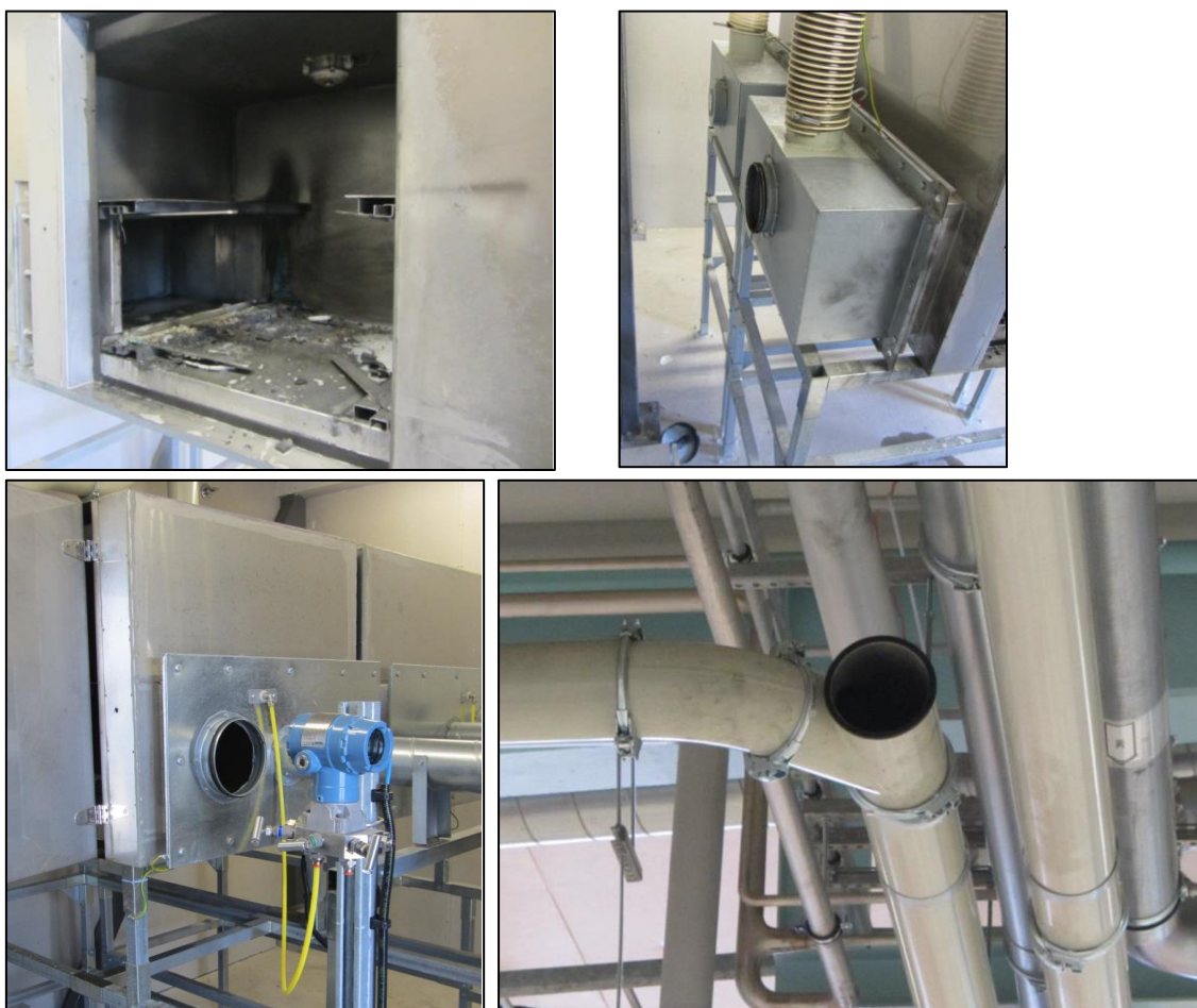
Figur 16. Foton som visar filterkabinettet där tryckavlastningar fungerade och öppnade som de skulle. Även en tryckavlastning i rörsystemet öppnade.
